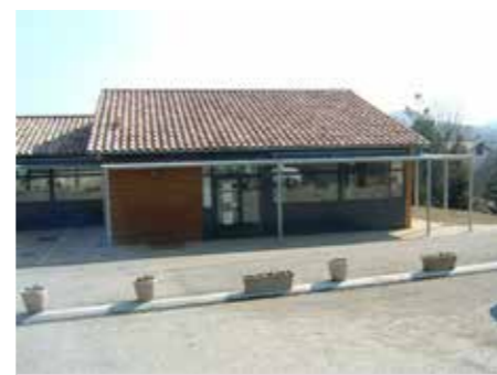
Médiathèque de Vazerac
