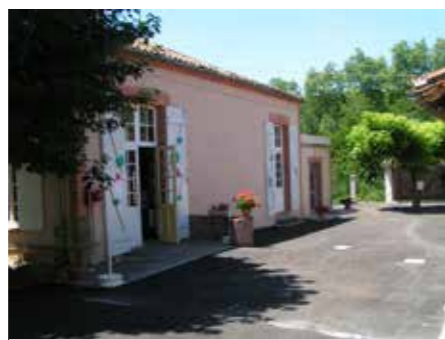
Médiathèque de Loubéjac
